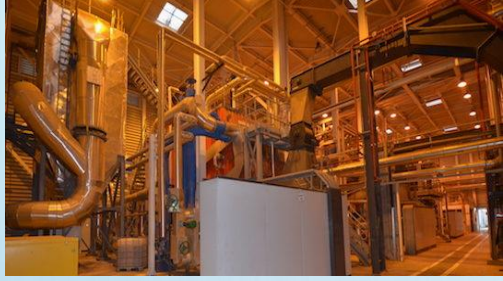
La chaufferie Renault de Tanger avec ses trois chaudières à biomasse VYNCKE,
