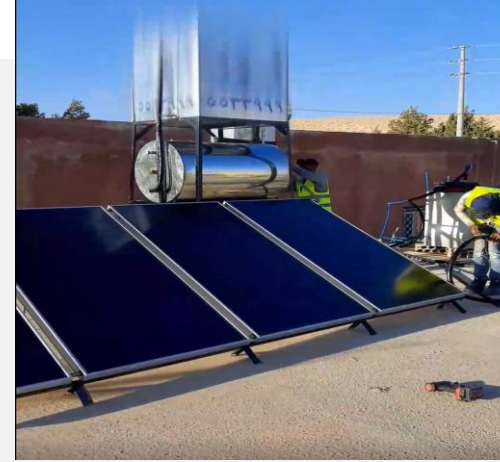
نظام طاقة شمسية سعة 4 كيلو واط، في مبنى سكني في بتير، الكرك، الأردن
