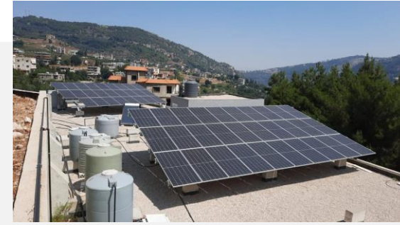
نظام طاقة شمسية سعة 25 كيلو واط، ونظام تسخين مياه في مبنى تعاونيات تصنيع مواد غذائية في عكار العتيقة، عكار، لبنان
